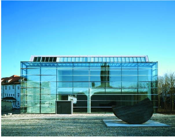
Abbildung 21: Alf Lechner Museum, Ingolstadt, (Nordwestseite) Der Glasvorbau mit dem Eingang verbindet das Luftvolumen von Erd- und Obergeschoß (12.590 m 3 ).
