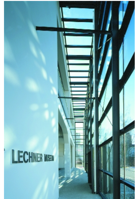
Abbildung 24: Alf Lechner Museum, Ingolstadt, Innenansicht des Glasvorbaus nach Südwest Ein „Schacht“ von 10 m Höhe ohne Thermik in der Heizperiode.
