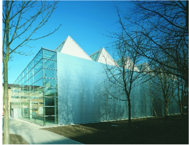
Abbildung 22: Alf Lechner Museum, Ingolstadt (Südwestseite) Die hinterlüftete Verkleidung hat 25 cm Abstand zur Außenwand.
